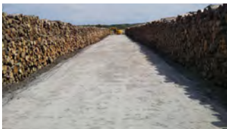
原木置き場のロバンダー材敷設した道路
