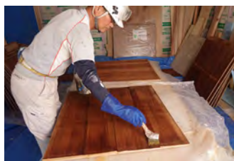
濾水（ろすい）跡洗浄の様子
