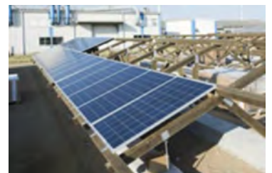
太陽光パネルと環境にも配慮した木製架台
