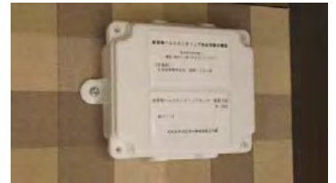
住宅の内壁に取り付けられたセンサー
