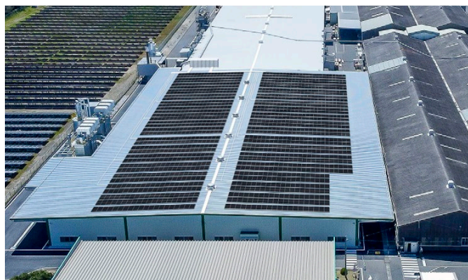
鹿島工場外観 太陽光パネル搭載工事は2020年9月に竣工予定
