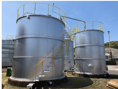
生物処理設備（曝気槽）
