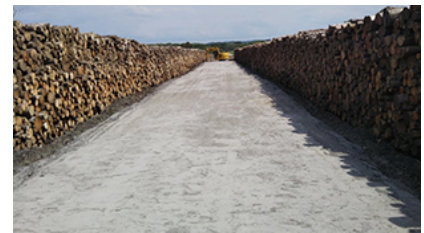
原木置き場のロバンダー材を敷設した道路
