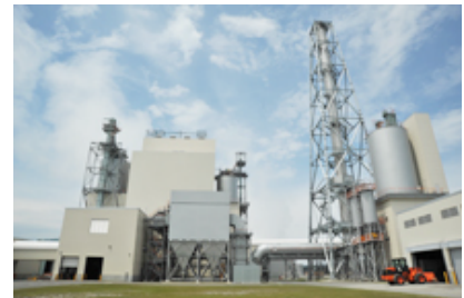
紋別バイオマス発電所
