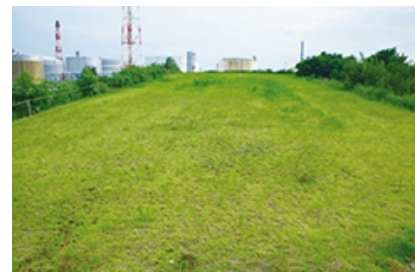
ガソリンスタンド跡地に施工されたシバ
