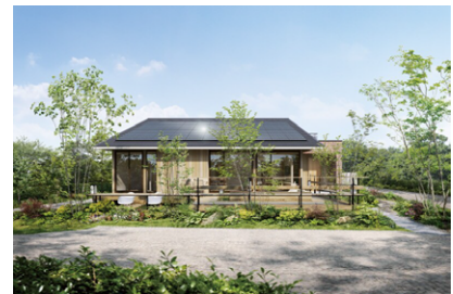
LCCM住宅モデルハウス「米子（木の家Lab.）展示場」
