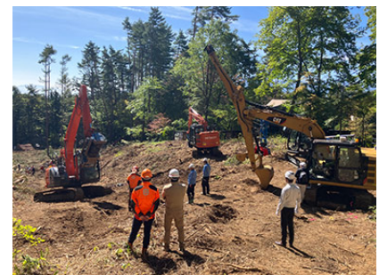
テザーを用いた作業の様子
