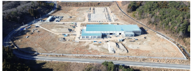
建設中の四倉工場（福島県いわき市）全景
