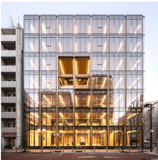
完成した新本社ビル
