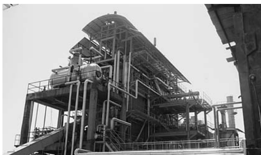
R P I 木質バイオマス発電設備
