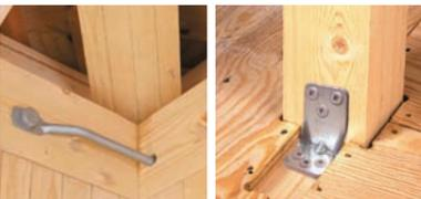
木造軸組構法は接合部が多いため、各接合部の性能が建物全体の耐力に大きく影響
