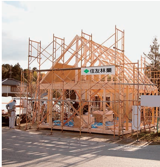
※6 / 「陸前高田 まちのリビングプロジェクト」仮設カフェ(建設中)
