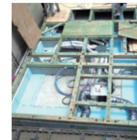
地下に設置される「澄家 Eco 換気システム」の全熱交換器
