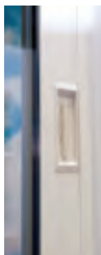
室外から見ると錠の位置が分かりにくいことも侵入犯を遠ざけるのにひと役買う。引違い窓の戸先錠は解錠・施錠の操作が簡単で分かりやすく、閉め忘れ防止に役立つ他、補助錠によって防犯性も高まっている
