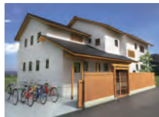
「四谷上町プロジェクト」珍しい新築木造2階建てのシェアハウス、無添加&自然素材で子育て環境にこだわる(施工: ぎざきホーム)
