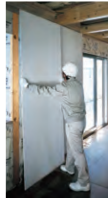
タイガーガラスロック耐力壁の施工の様子
