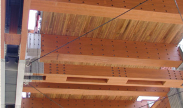
橋の下からみた床版。横桁の上に橋軸垂直方向に並列配置した様子がわかる
