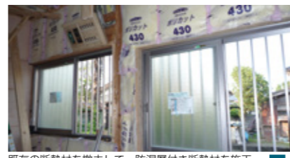
既存の断熱材を撤去して、防湿層付き断熱材を施工
