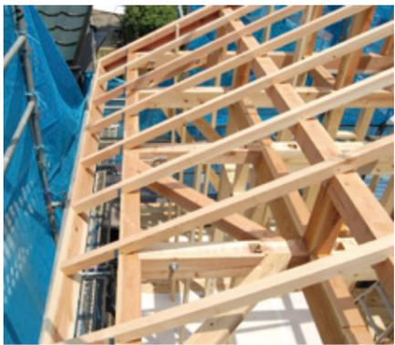
しているということもできる。また、曲げに弱いスギを、曲げに強いベイマツで挟むなど、弱点を補強したハイブリッド材などの新商品も梁や桁に使われている。
