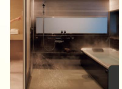
入浴前に脱衣所でスイッチを押すと、カウンターから床に向かって湯のシャワーがワイドに噴出。1分\*1で床面の温度を25℃まで上昇させ、浴室を足元から温める。
