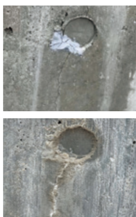
(上) ひび割れから多量の漏水 (下) 約2週間まで止水、その後1 ~1カ月半で自己治癒
