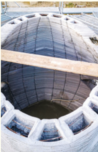
構造躯体の内部。壁内は空間が広がり鉄筋がのぞく
