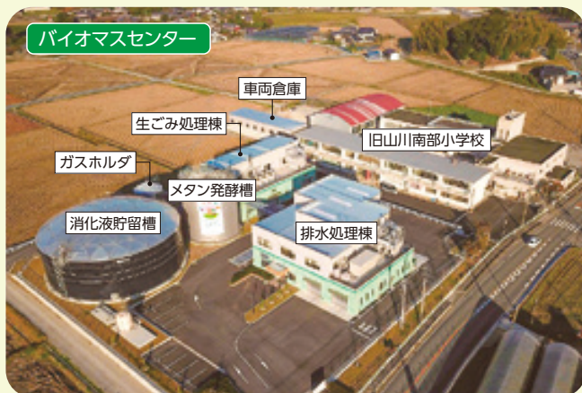
みやま市バイオマスセンター ルフラン
