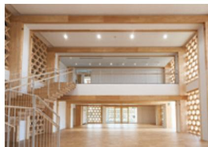
木造軸組工法による耐震構造、施工面積: 6165.95㎡、高さ: 最高高さ 30.93m (右) 組子格子耐力壁が現しのエントランスホール
