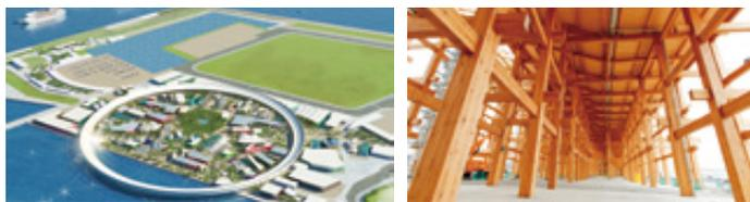
2025年4月13日~10月13日@大阪 夢洲 (右) 全周約2km大屋根リングの下、迫力ある木組みの空間。国産材として柱材の約50%程度に四国産のヒノキ、梁材には福島産のスギを採用(大林組JV施工工区)
