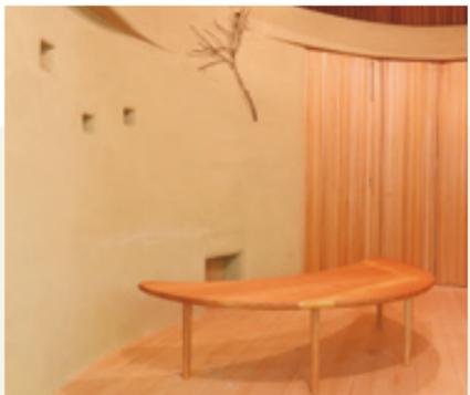
「Shell house」: 信州の森の中に建つ「土から生まれ土に還る」別荘建築。伝統的な木組み構法で、新建材はいっさい使わず地域の木と土で造られた。一つの生命体をイメージし、周囲の森に溶け込むように共存する木材と土壁によって、大自然に包まれているような安堵感を得られる。(左) 小上がりのあるリビングルーム。長野の土を使った版築の暖炉と塗り壁が部屋に柔らかさを醸し出す。(中) 2階の寝室の天井は蕪束(かぶらづか)\*\*4の木組みで、杉の木摺(ぎざり)をドーム状に貼ったものに土を塗り重ねている。(右) たまごを半分に割ったような外観が森に溶け込む。
