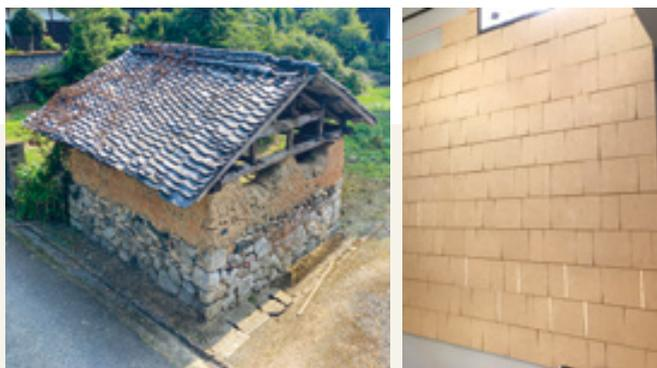
山田宮土理氏の活動の一例：各地にあるこれまでの土建築について記録し、環境に配慮したこれからの土建築のあり方を探る。(左) 西日本の農村に残る土で造られた小屋。(右) 土の新たな活用として、土を焼成せずにタイルにし、住宅の内装仕上げに使うプロジェクト。はめ込み式なので取り外しが容易でそのまま土に還る。
