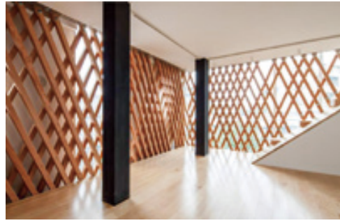
下馬の集合住宅(東京都/2013年) 1階は2時間耐火のRC造、2～5階は1時間耐火の木造。木造部分は集成材の柱とフラットスラブが鉛直力を支え、外周を覆う木の斜め格子が水平力を負担し、居住空間を柔らかく包みこむ
