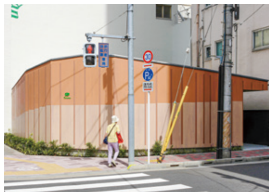
老舗パン店の倉庫棟（東京都）。外周は特殊な防腐・防蟻処理（ニッサンクリーンAZN乾式加圧式保存処理）を施し、シリコン系木材保護塗料（S-100）で染色した24mm厚のヒノキ合板で覆っている
