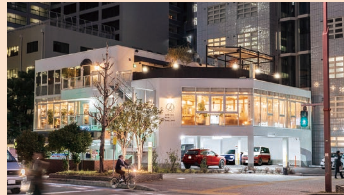
1階をコインパーキングとして活用し、その上部空間に空中店舗を設ける「フィル・パーク」。飲食店、ヘアサロン、フィットネスジムなど様々なテナントが入居する
