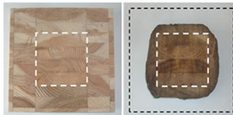
加熱前後の柱部材断面
