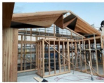
事務所棟CLTトラス建て方状況(2)
