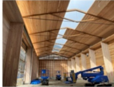
倉庫棟SSP建て方状況
