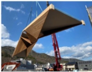
事務所棟CLTトラス建て方状況(1)
