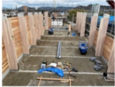
倉庫棟CLT壁柱建て方状況
