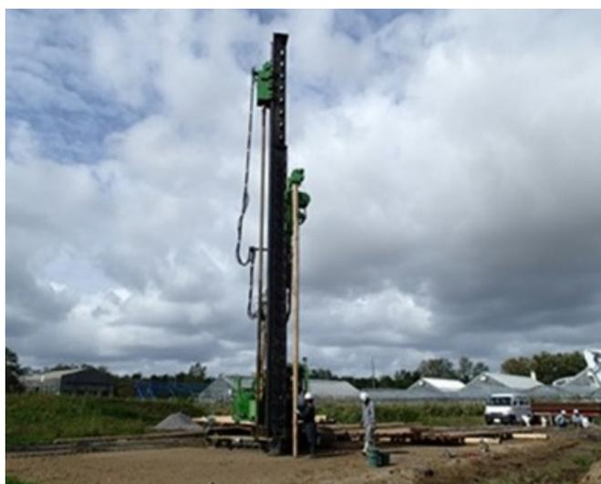
写真-1 丸太打設の様子
